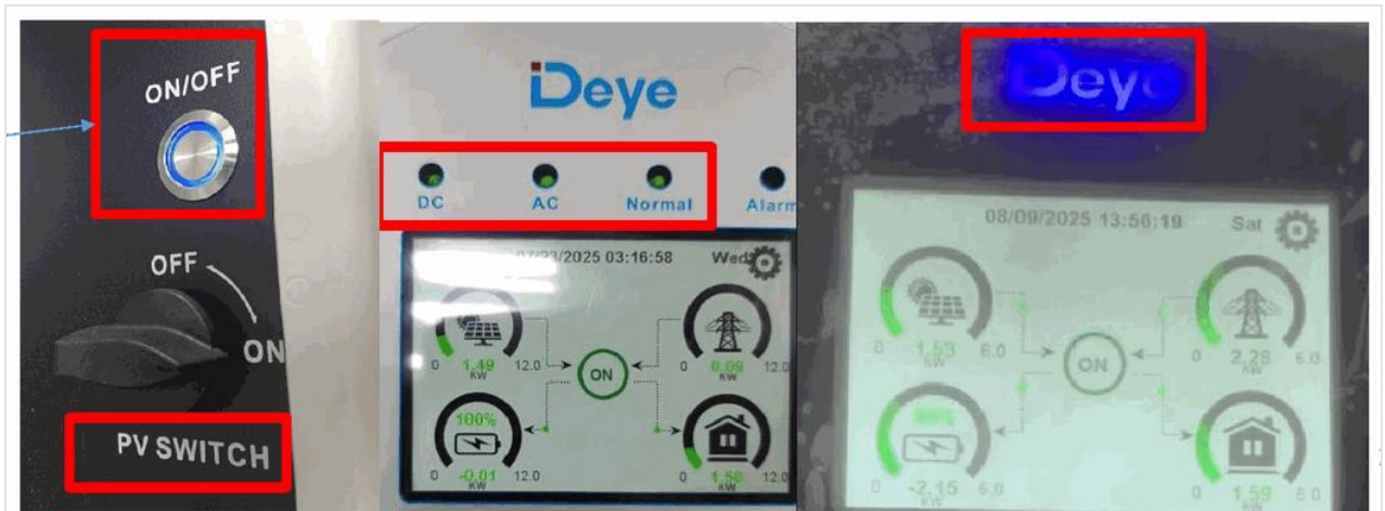
Hình 3.6b — Vị trí nút ON/OFF BAT và PV SWITCH trên thân máy; màn hình vận hành với các đèn DC / AC / Normal / Alarm.
